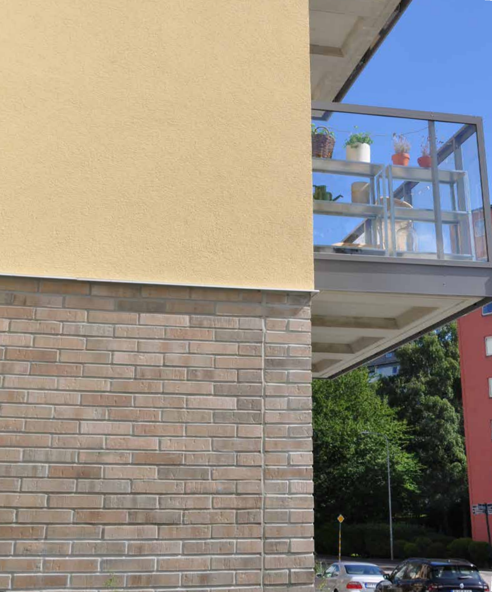
Exempel på utförande av ytterhörn och fältavgränsning.
