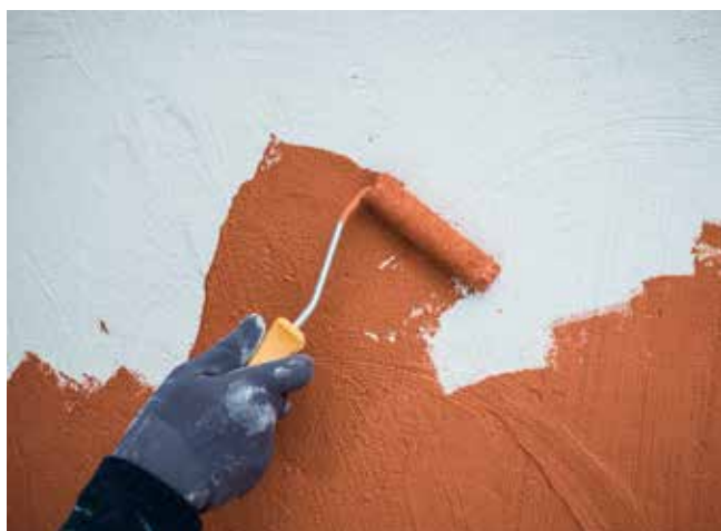
Putsgrund 610 bryts i samma kulör som ytputsen och appliceras över hela ytan.
