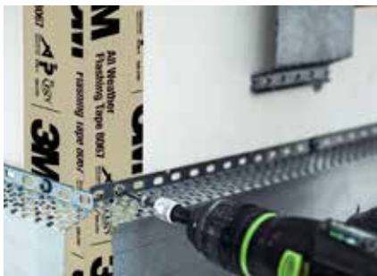
Montera VFL så att underlag skapas för Profil L 50/50.
