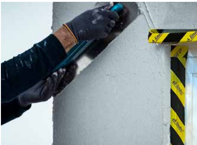
Vid andra påslaget skall putsbruket helt täcka armeringsvävens maskor.
