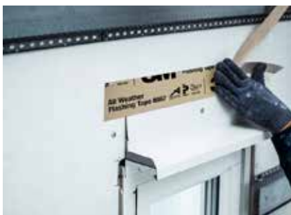
Montera under- och överbleck ovanför fönster. Täta med godkänd tätningstejp.
