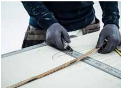
Märk upp ditt mått på skivan och skär igenom väven med kniv. Använd med fördel skivlinjal.
