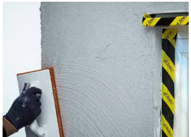
Därefter monteras armeringsväv. Armeringsväven överlappas min 100 mm mot anslutande väv och hörnvinklar
