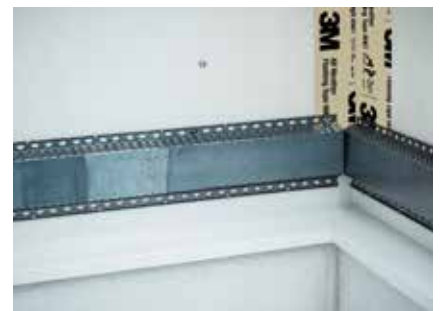
Därefter monteras VFL.
