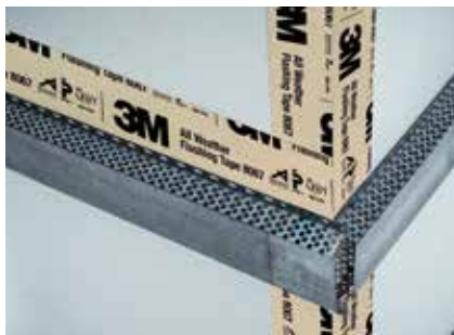
Montageexempel, VFL, ytterhörn
