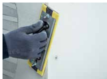
Vid behov slipas kanterna med slipkloss.
