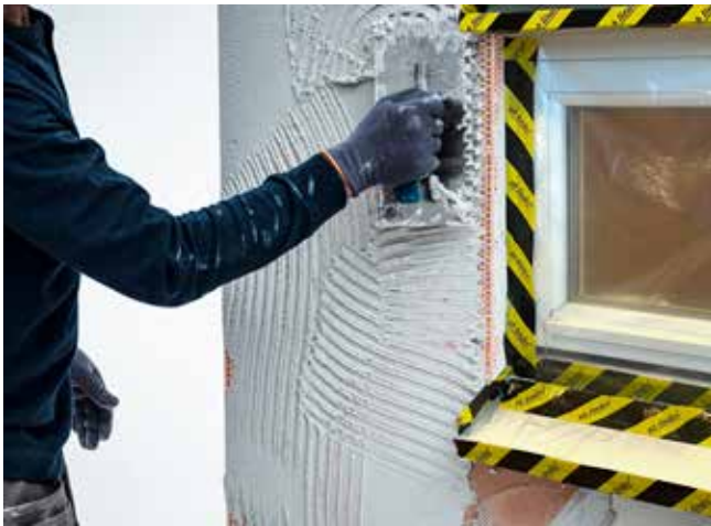
Vid första påslaget appliceras grundputs på hela ytan.
