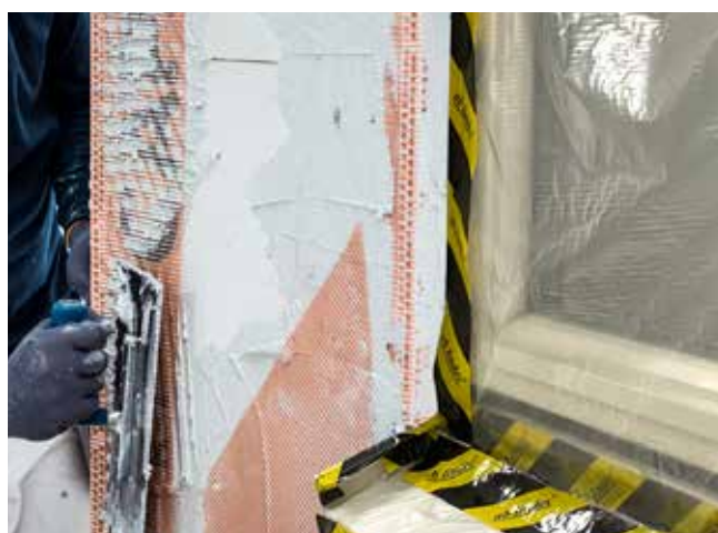
Samtliga armeringsdetaljer sätts i Putsbruk 133.
