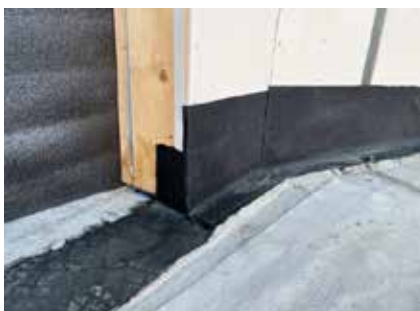
Bitumentätskikt vid socklar och dörrar.
