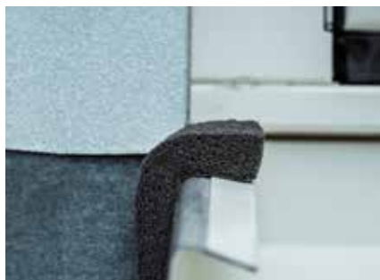
Korrekt monterat fogband
