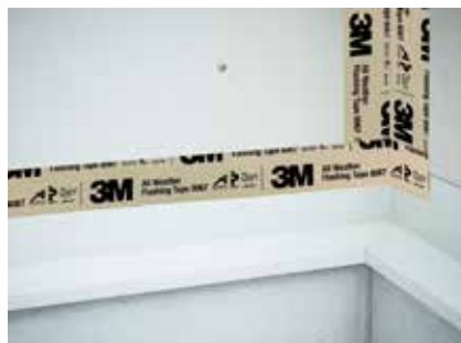
Montera godkänd tätningstejp mellan plåtbleck och vindskyddsskiva.
