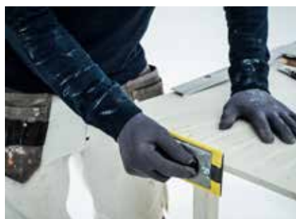
Skär av väven och slipa kanterna på skivan vid behov för att säkerställa ett tätt montage mellan skivorna.
