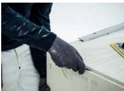
Skär av väven och slipa kanterna på skivan vid behov för att säkerställa ett tätt montage mellan skivorna.
