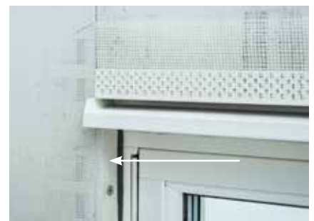
Montera Capaboard Fasadskiva med fogband mot karmsida fönster och fönsterbleck.
