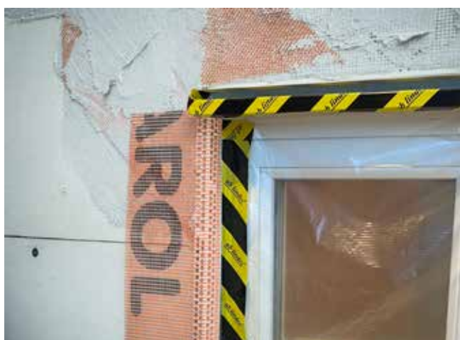
Runt alla ytterhörn samt fönster- och dörrsmygar monteras hörnvinkel.
