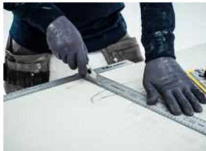
Märk upp ditt mått på skivan och skär igenom väven med kniv. Använd med fördel skivlinjal.
