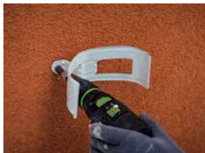
Därefter montera stuprörssvep.
