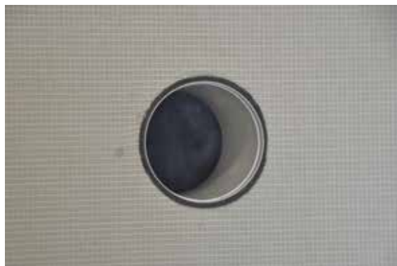
När skivan monterats tätas genomföringarna med fogband 600.
