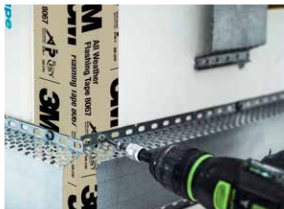
BILD OVAN: Montering ventilerad fasadläkt
