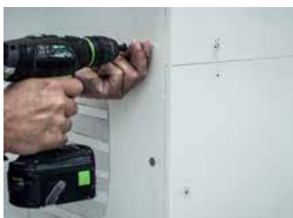
Montera Capaboard Fasadskiva. Skruv ska dras i nivå med skivan.
