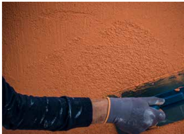
Det rekommenderas att handskura ytputsen för att säkerställa rätt påförd mängd.
