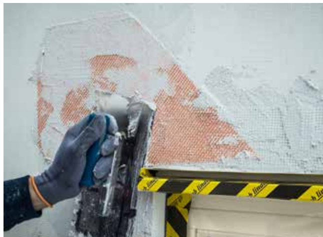
Samtliga armeringsdetaljer sätts i Putsbruk 133.
