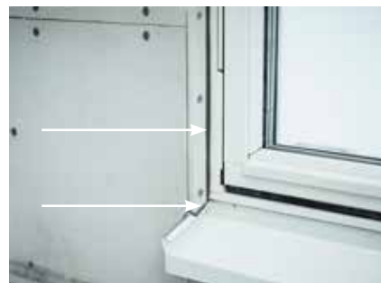
Fogband monteras mot karm och fönsterbleck.
