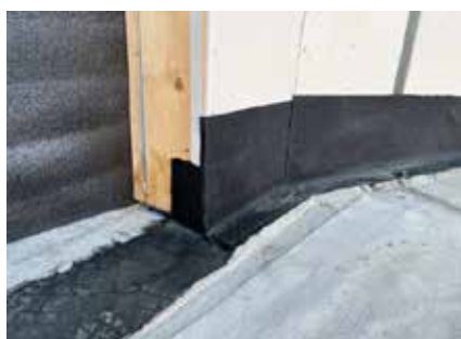
Bitumentätskikt vid socklar och dörrar.
