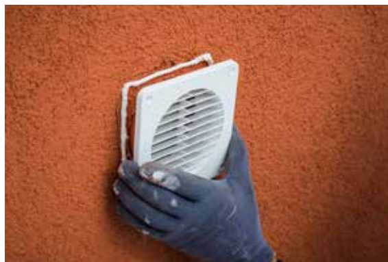
När puts och ytskikt är klart appliceras fogmassa där ventilkåpan kommer att ansluta mot putsen. Montera ventilkåpan och skruva fast kåpan.
