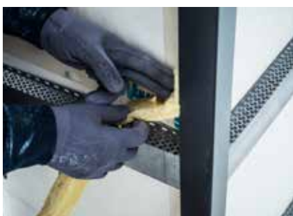
Dreva varje ytterhörn. Detta görs för att stoppa luftflödet runt inner- och ytterhörn.
