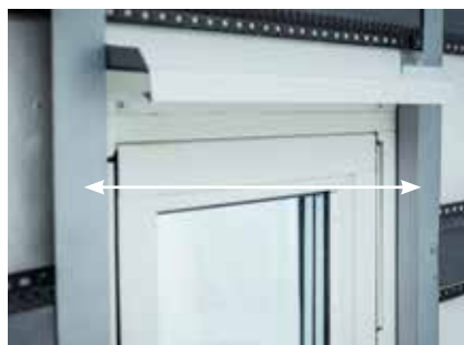
Montera Profil L 50/25 som stöd för infästning av fönstersmygar.
